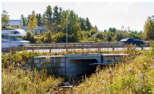
FIGURE 2 Ponceaux aménagés pour la faune près de la sortie 115 à Magog, à la suite des travaux réalisés en 2020. (Mention de source : Charles Dion)
