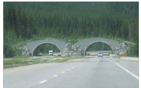
Figure 55 : Passage aérien, Alberta.
